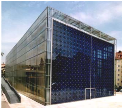
Abbildung 1: Ansicht von außen
