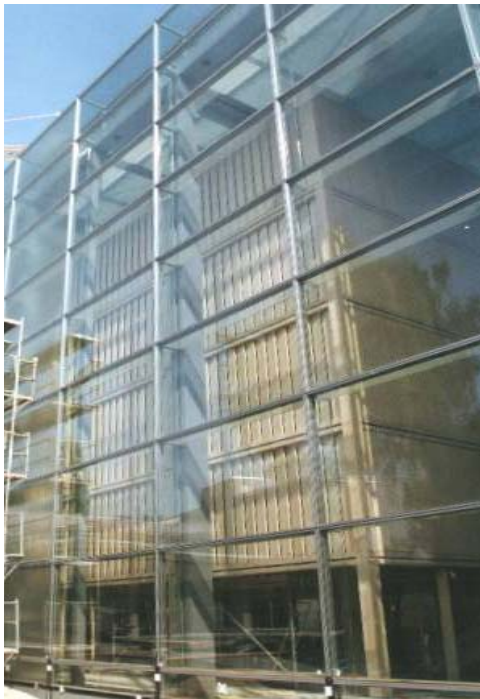
Bild 1: Ausschnitt Glasfassade der Herz-Jesu Kirche
